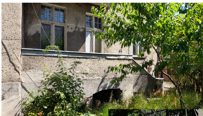
BALKON PARTER – UBYTKI W TYNKACH
